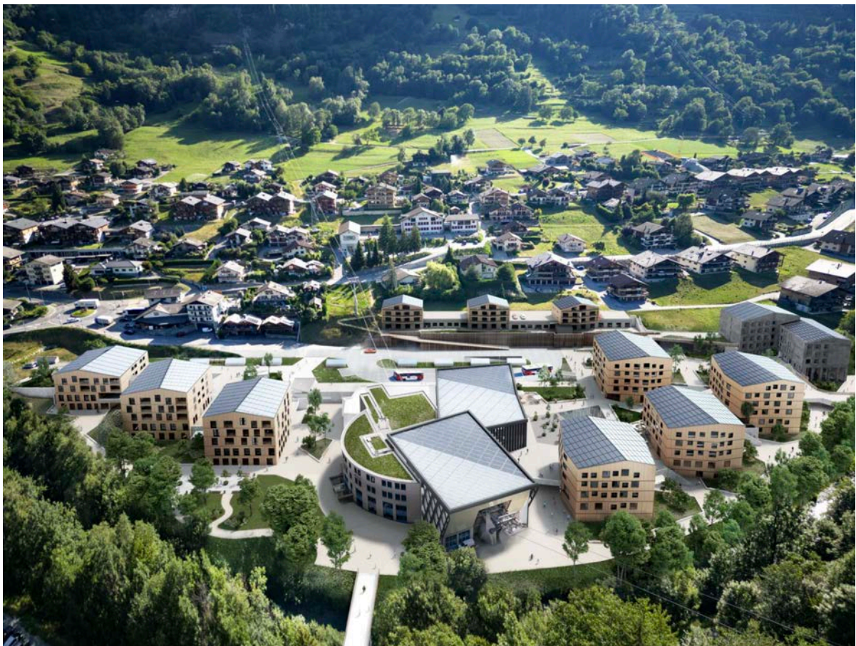
Figure 28 : Vue d'ensemble du futur quartier de Curala, image de synthèse par l'agence dix-sept sur la base du projet du groupement fima-comina.
